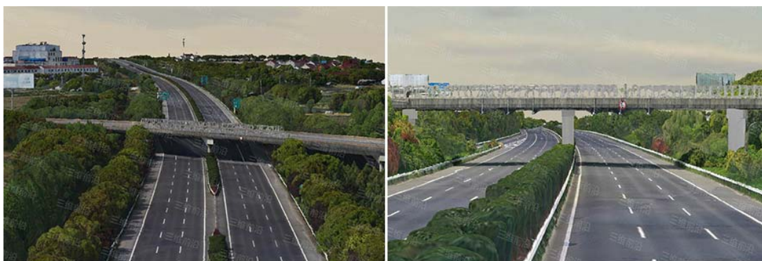
图 6 桥洞修复前 VS 桥洞修复后
